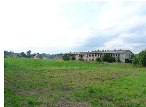
obr. č. B. 54: Zchátralý objekt zemědělského areálu ve Stanovicích
