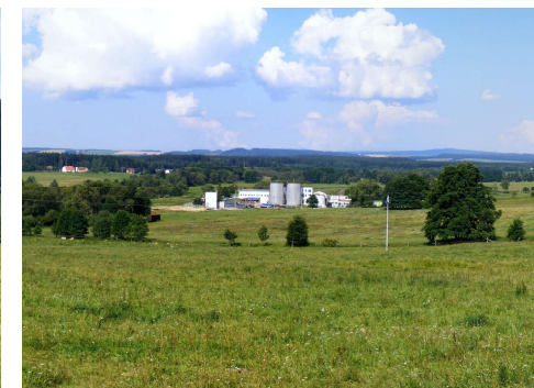
obr. č. B. 17: Areál kalového hospodářství; v pozadí hřeben severní části Českého lesa
